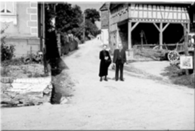
Dorfmitte (um 1940), Wohnhaus, Stall und Scheune der Fam. Vollrath 2010 abgerissen
