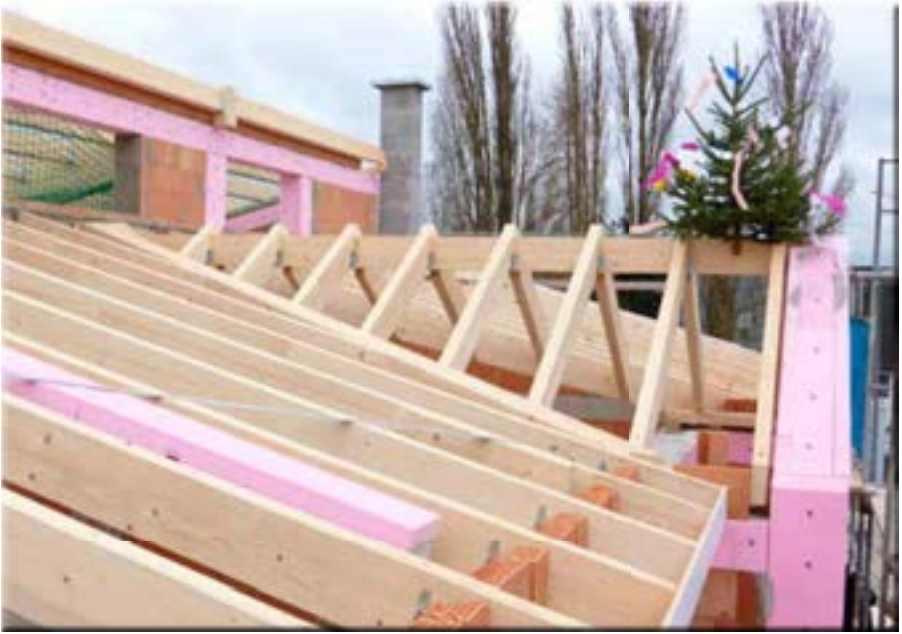
Rohbau Neubau Gemeindehaus (Ansicht Süd-Osten)
