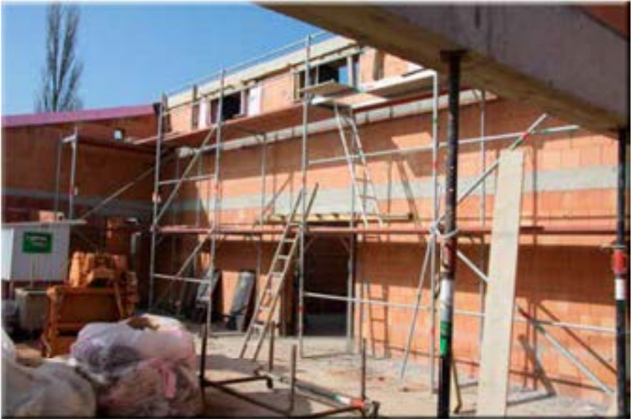
Rohbau Neubau Gemeindehaus
