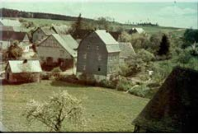
Altes Backhaus im Unterdorf mit Bieberbach (um 1935)
