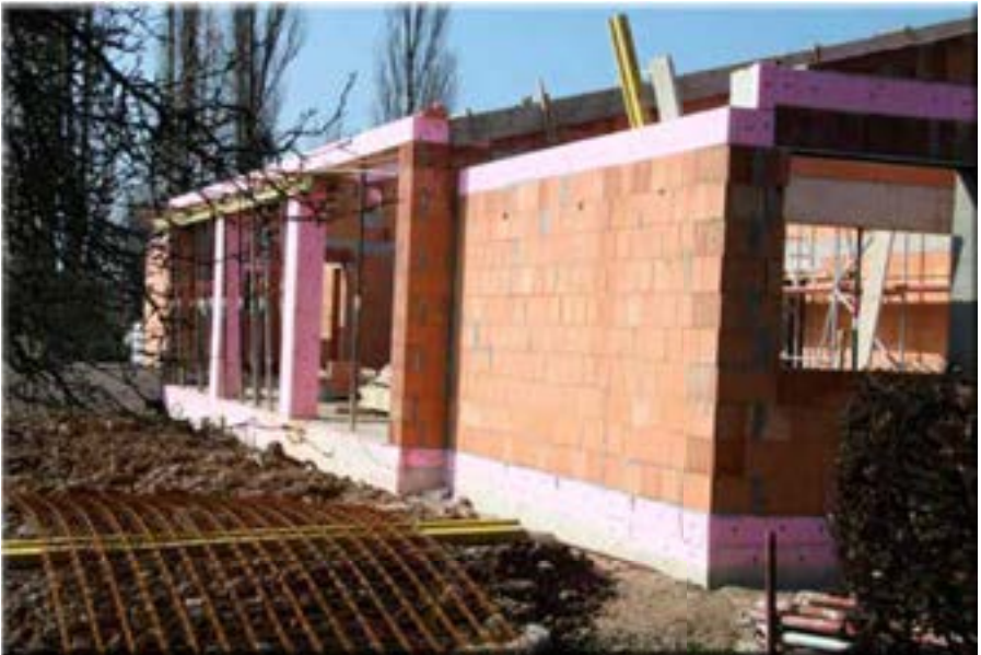
Rohbau Neubau Gemeindehaus (Festsaal)
